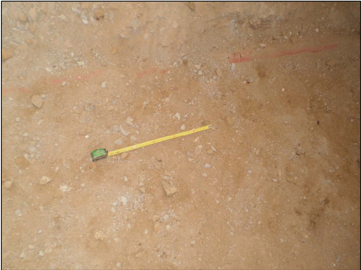
Tub de corrent general a la cota 6.02.
