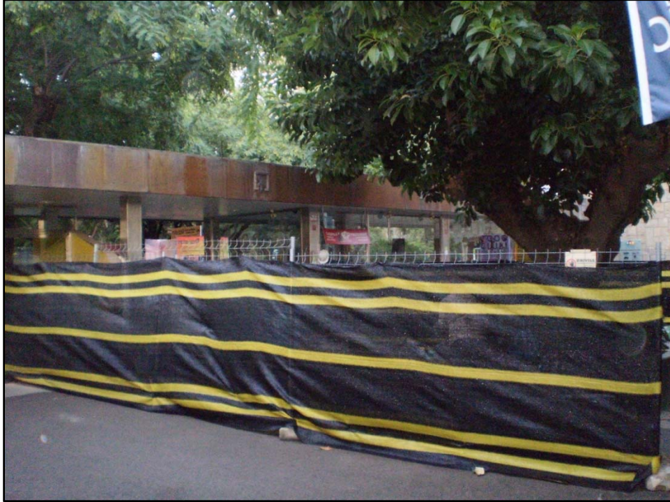
Taquilles Wellington i tancat que tapa les obres de renovació.
