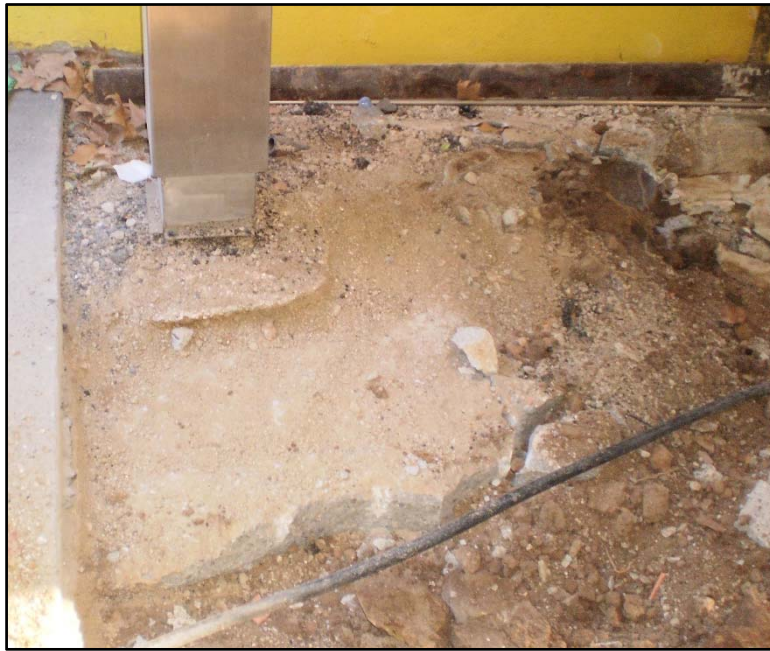
Fonamentació de la columna esquerra de la zona2.
