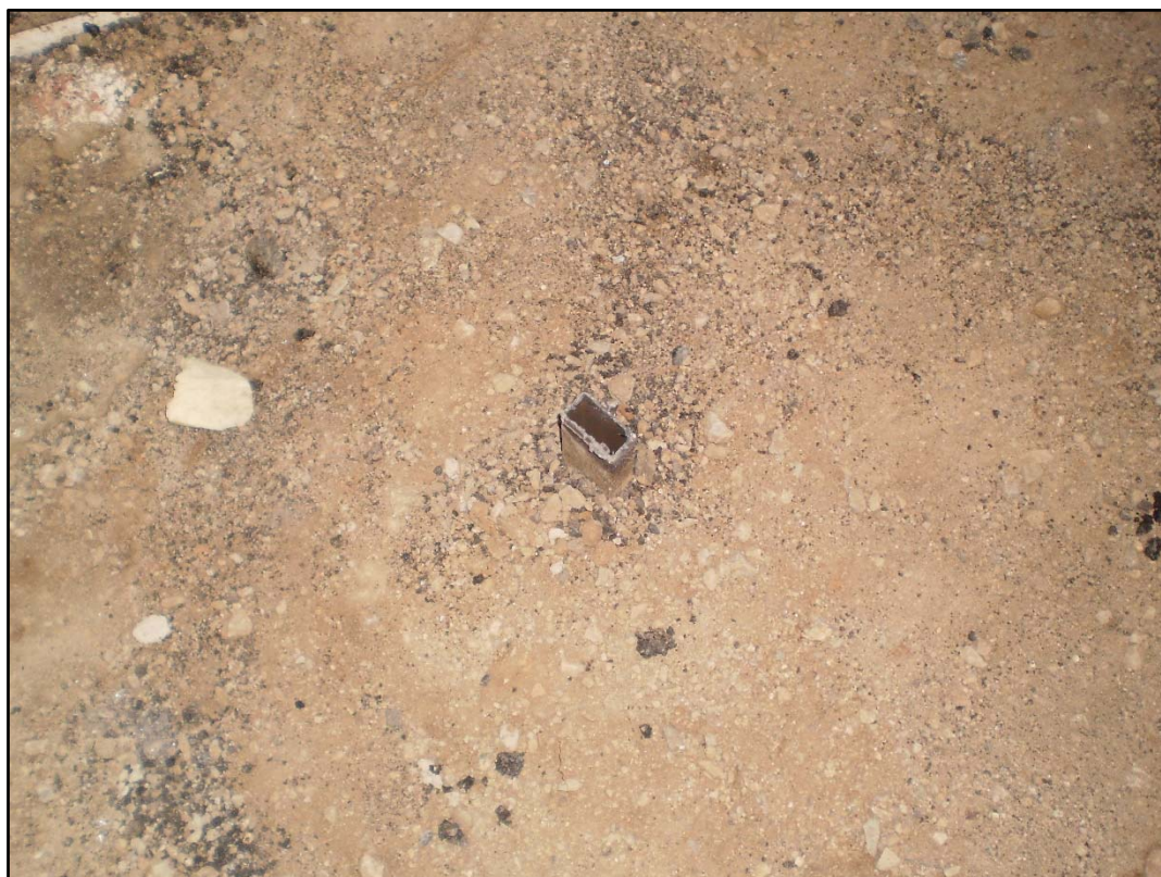
Encoratge lateral del torn zona2.
