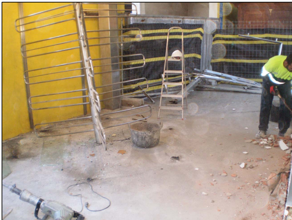
Extracció del torn de sortida zona 2.
