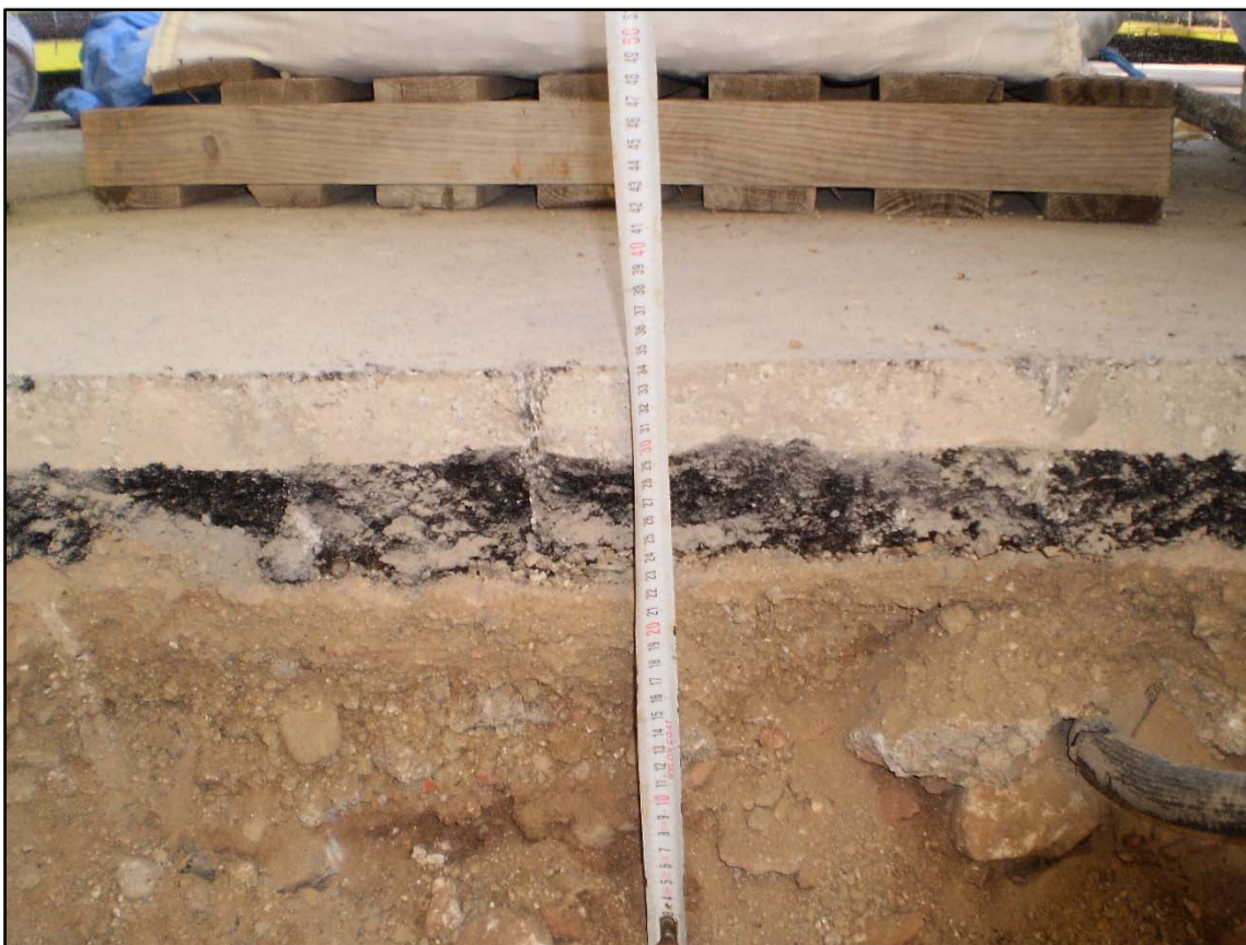
Perfil sud del rebaix del terreny de la zona1.
