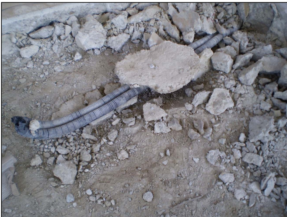
Tubs amb el formigó que els subjecte.
