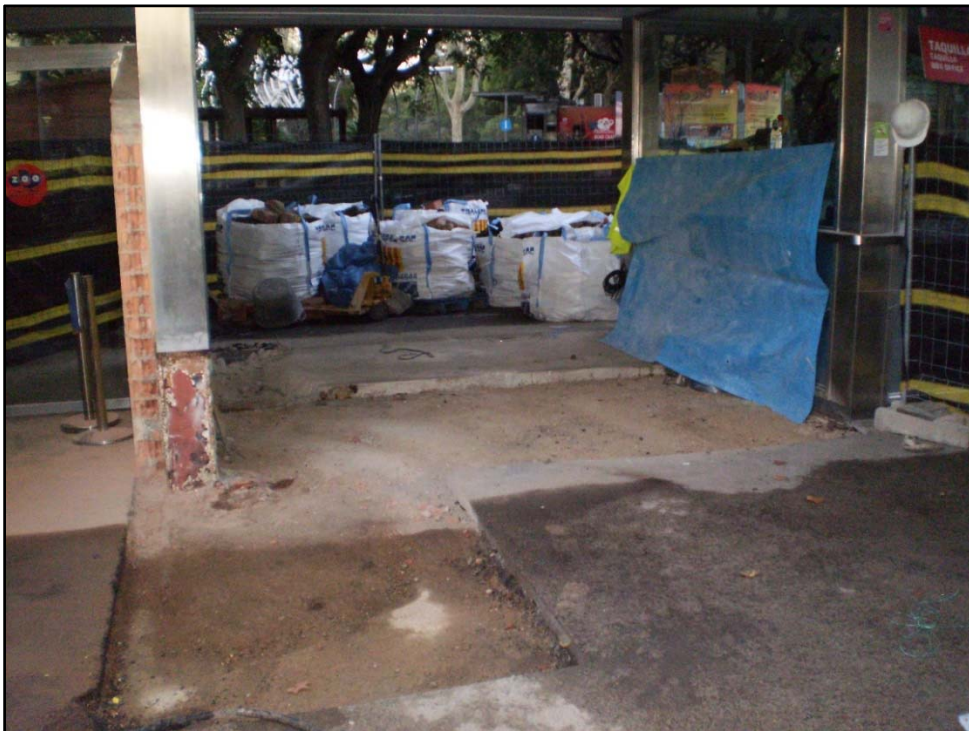
Espai zona1 on es produeixen els rebaixos. En aquest moments, l'extracció de la solera. A la part esquerra podem veure la paret i una de les columnes que divideix les dues zones.
