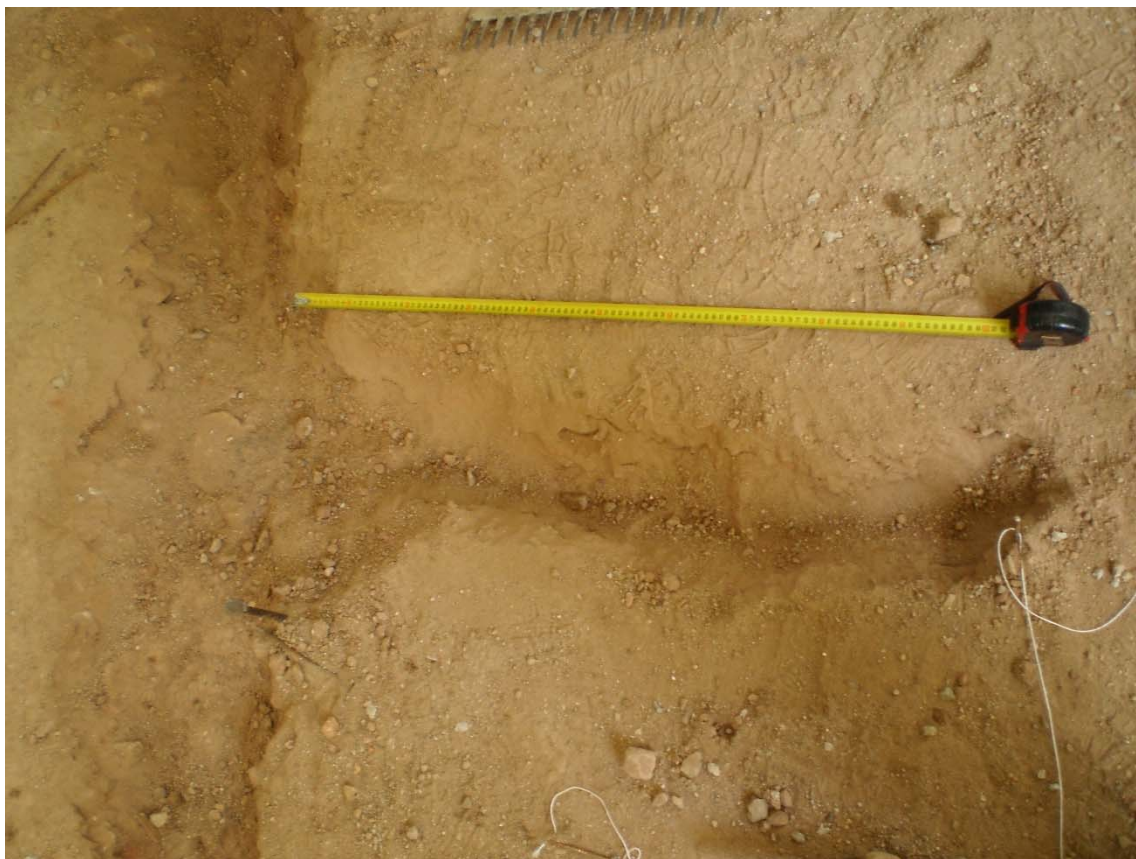
Rasa secundària per a un tub concret zona1.
